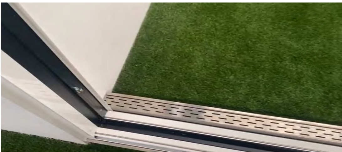
Canal de drenaje con rejilla.
